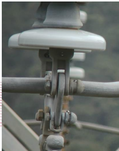
螺栓穩定性檢查
